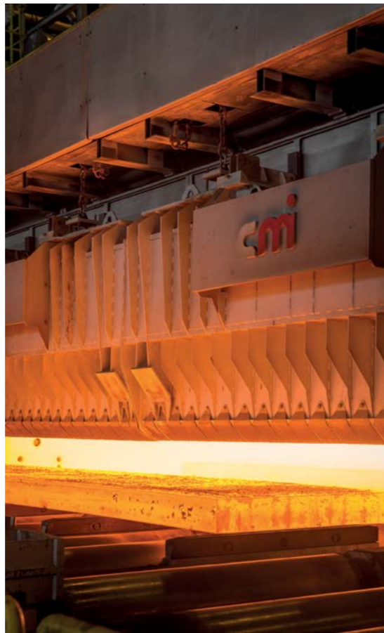
Une brame quitte le nouveau four à longerons mobiles peu énergivore à Gand.
