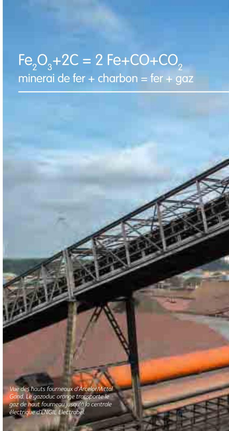
*Vue des hauts fourneaux d'ArcelorMittal Gand. Le gazoduc orange transporte le gaz de haut fourneau jusqu'à la centrale électrique d'ENGIE Electrabel.*
