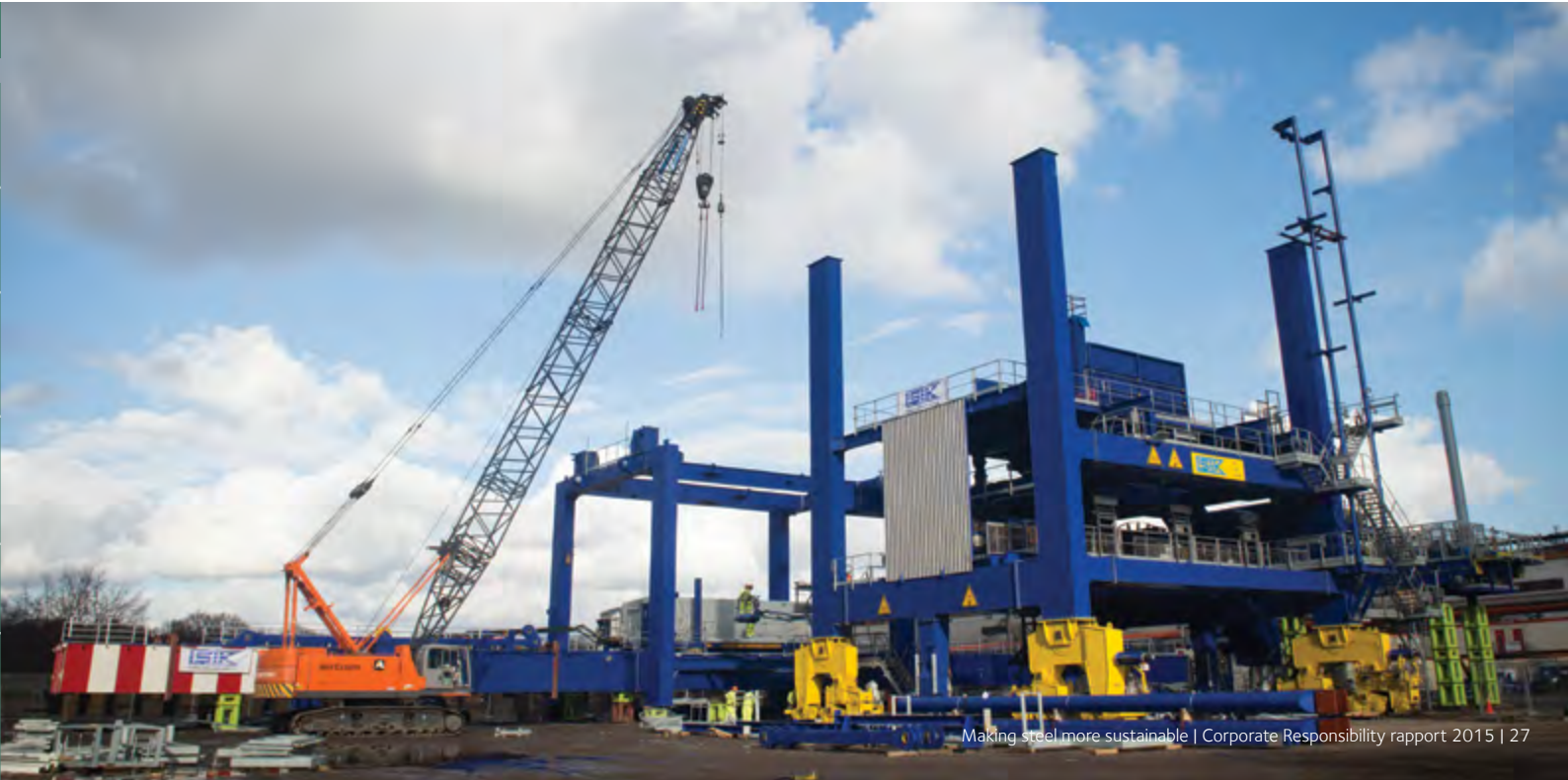
Opbouw van onze nieuwe havenkraan, uitgerust met een sproeisysteem dat stofvorming van de grondstoffen voorkomt.
