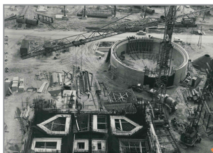
ArcelorMittal Gent in opbouw
